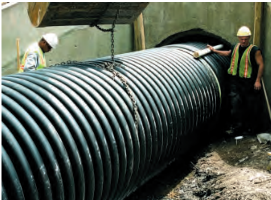
Рис. 1. Санация железобетонной трубы в Уилмингтоне, штат Делавэр
