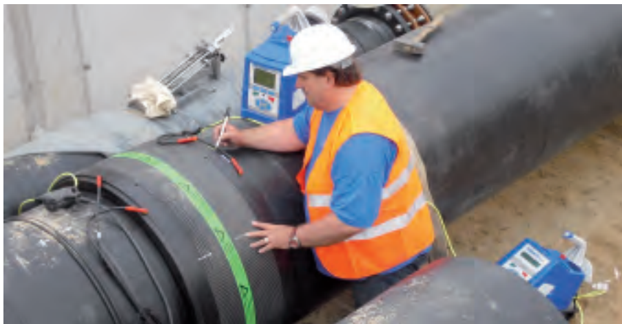
Рис. 2. Внешнее армирование препятствует расширению муфты при выполнении сварного соединения
