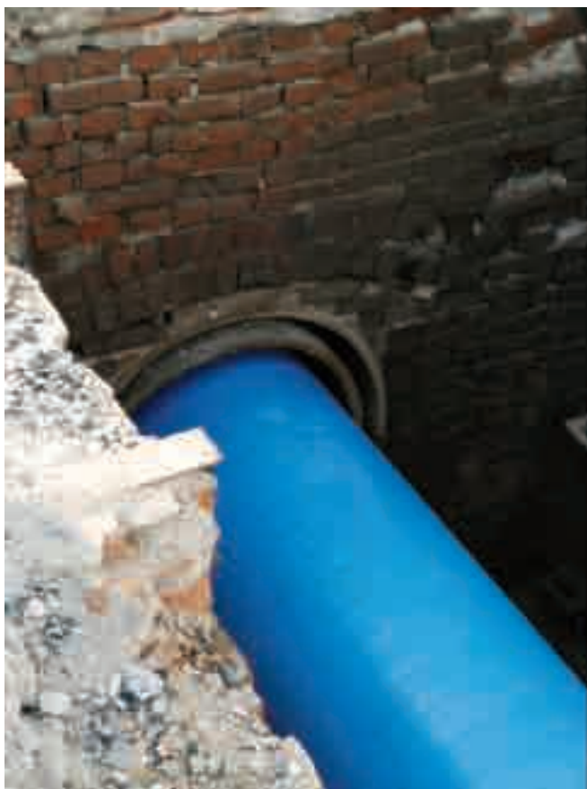
Рис. 7. Протягивание труб ПРОТЕКТ.
