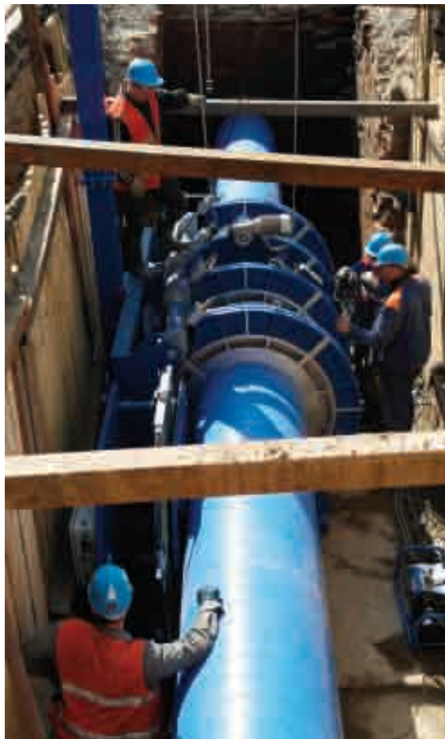
Рис. 6. Обустройство сварочного участка на дне траншеи.
