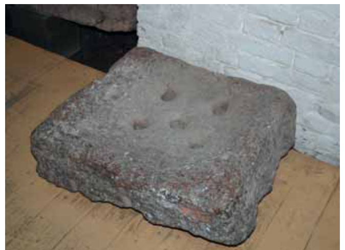
Рис. 5. Гранитная крышка канализационного люка XIX в.
