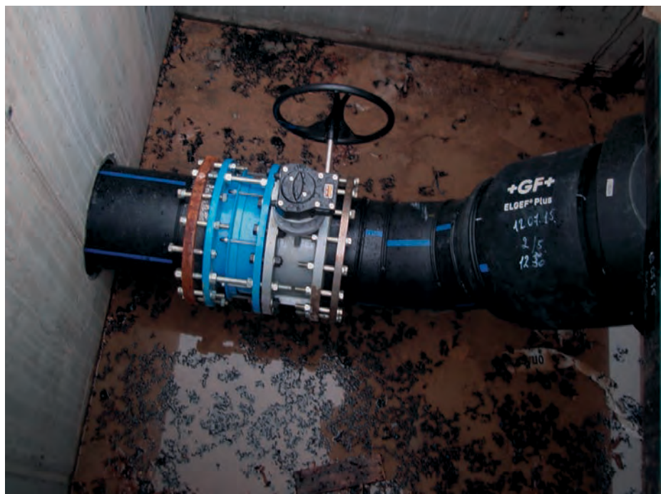
Рис. 2. Смонтированная врезка
