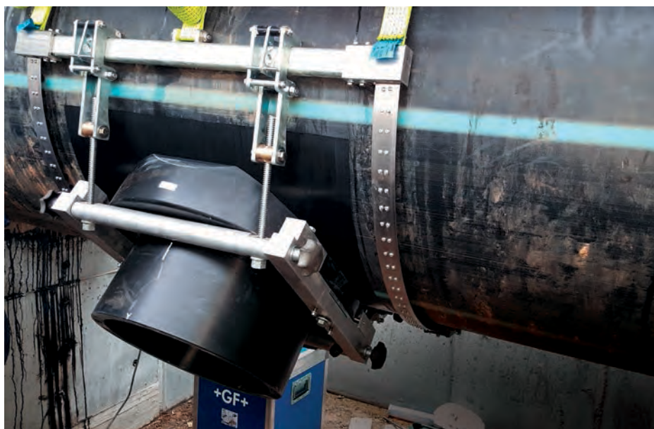
Рис. 1. Установка седелки на трубу
