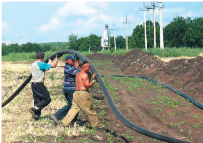
Рис. 2. Укладка в траншею выкидного нефтепровода
