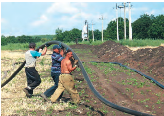
Рис. 2. Укладка в траншею выкидного нефтепровода
