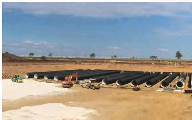
Рис. 4. Строительство ПЭ резервуаров
