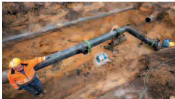
Рис. 4. Подключение/ремонт участка водопровода
