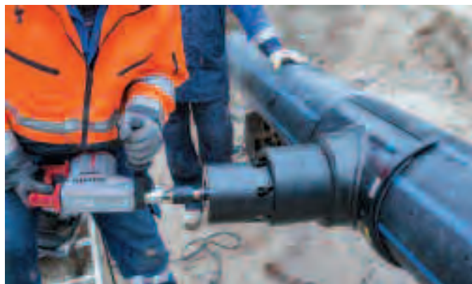
Рис. 2. Врезка в трубу
