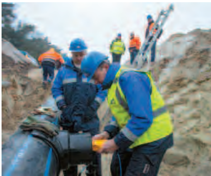
Рис. 3. Введение ремонтного баллона
