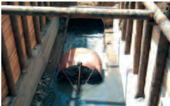
Рис. 3. Очистка лотка коллектора
