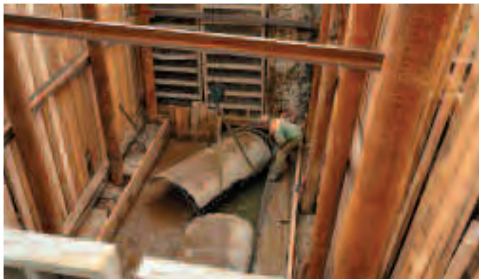
Рис. 2. Вскрытие свода коллектора
