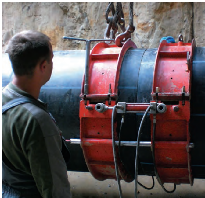
Рис. 5. Двуххомутовая машина не гарантирует хорошей центровки
