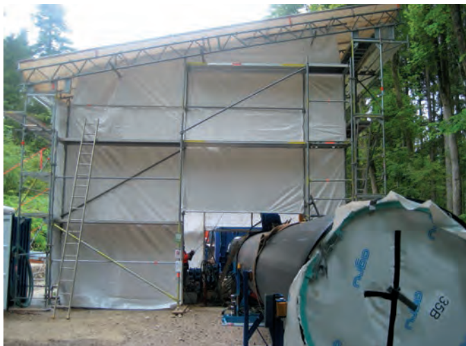
Рис. 3. Палатка при сварке трубы диаметром 1600 мм на объекте в Германии
