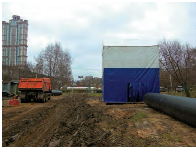
Рис. 4. Применение объемной палатки на российском объекте
