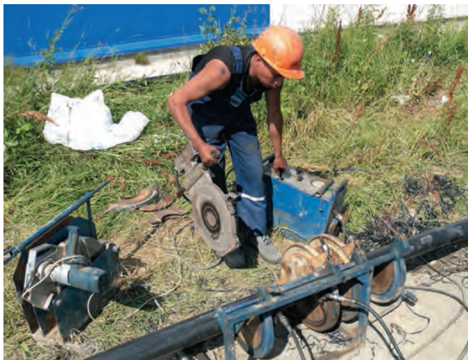
Рис. 1. Сварка без двух хомутов – крайне легкомысленная «рационализация»
