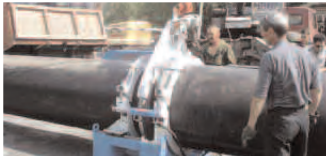
Рис. 6. Пример использования машины двуххомутной конструкции, не адекватной поставленным задачам
