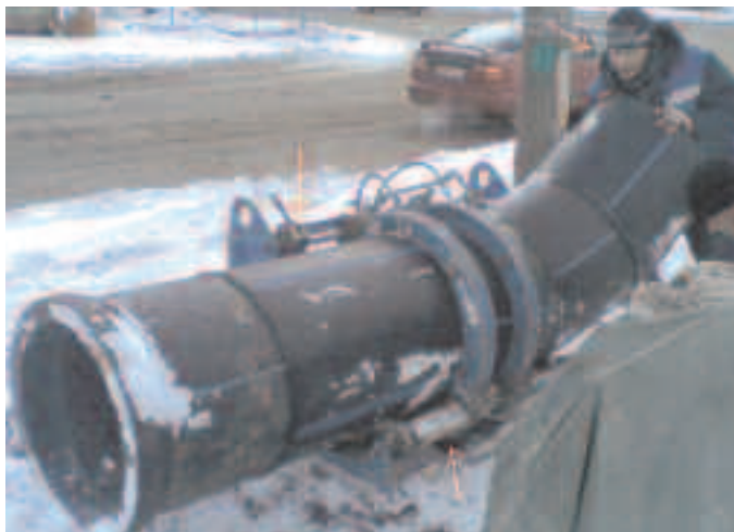
Рис. 1. Пример некорректной фиксации заготовок
