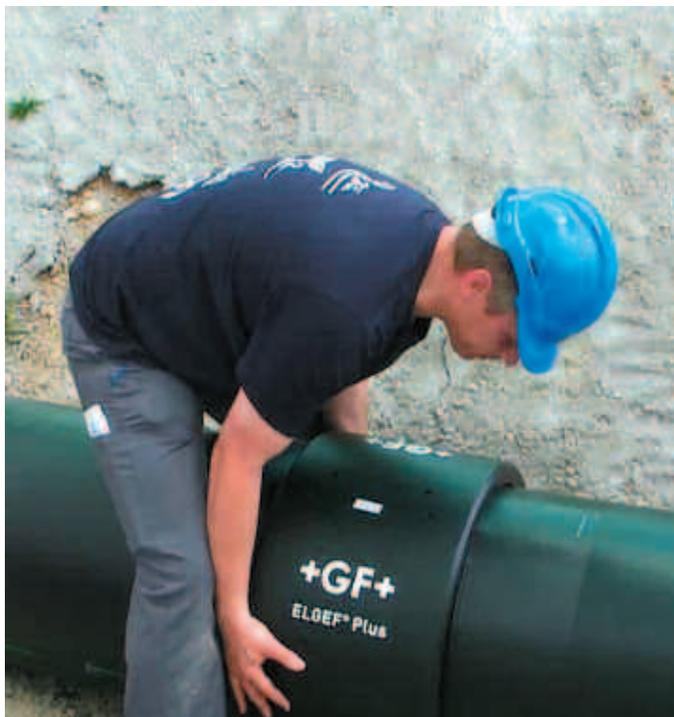
вательной проволоки. При пропускании через нее электрического тока выделяемое ею тепло разогревает и размягчает внутренний корпус муфты, что снижает его жесткость. Наружный корпус, стремясь вернуться в своё первоначальное состояние, активно давит на внутренний корпус по всей его окружности, что приводит к непрерывному уменьшению его внутреннего диаметра вплоть до полного прижатия к поверхности трубы. Таким
