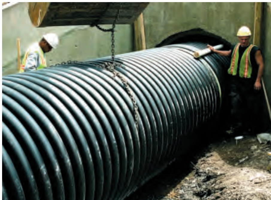
Рис. 1. Санация железобетонной трубы в Уилмингтоне, штат Делавэр
