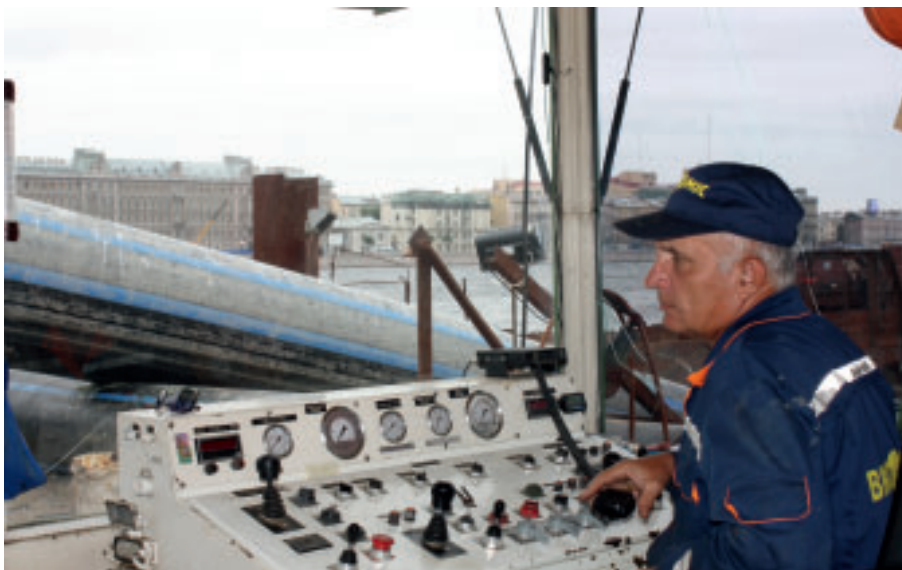
Протягивание резервной нитки (Арсенальная набережная)
