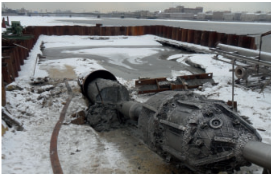
Выход оголовка трубы «береговой» нитки на Петровской набережной
