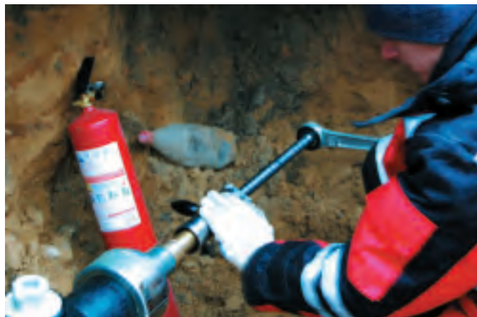
Врезка в действующий газопровод диаметром 225 мм SDR 11 с последующим присоединением отвода диаметром 160 мм (г. Петушки, Владимирская область)
