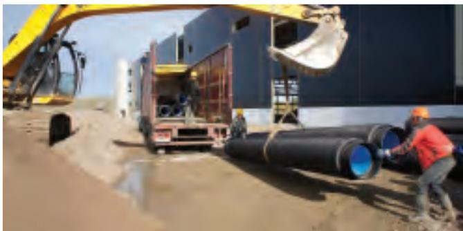
В результате для строительства ССП было поставлено более 1 км труб КОРСИС ПРО диаметром 1000 мм, более 2 км труб КОРСИС ПРО диаметрами 250–630 мм и труб ПРОТЕКТ диаметрами 110–560 мм.
