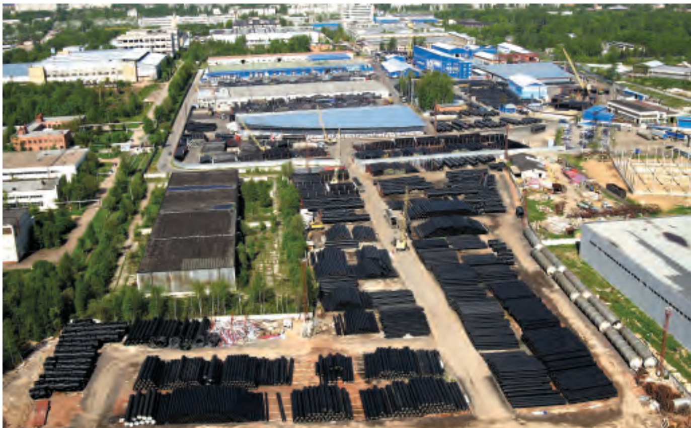
Площадка Климовского трубного завода летом 2008 года
