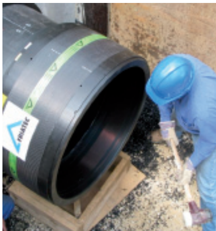
Рис. 1. Соединения при помощи цилиндрическими муфтами требуют приложения больших физических усилий из-за больших допусков
