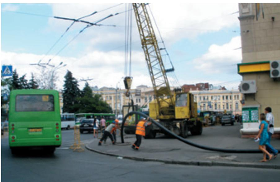
Весь монтаж двух участков в общей сложности 130 м трубопроводов занял считанные часы вместо традиционных недель напряженного труда. Получив качественную и бесперебойную услугу теплоснабжения, жители района даже не ощутили дискомфорта в связи с проведением ремонтных работ. Также не потребовалось дальнейшего благоустройства мест разрытий, т.к. все работы выполнялись без вскрытия асфальтобетонного покрытия и зеленой зоны.
