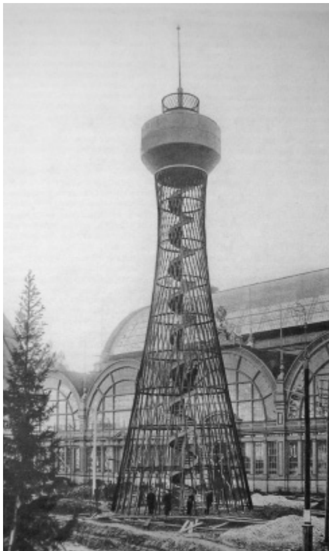
Первая в мире гиперболическая конструкция – водонапорная башня. Нижний Новгород, 1896 г.
