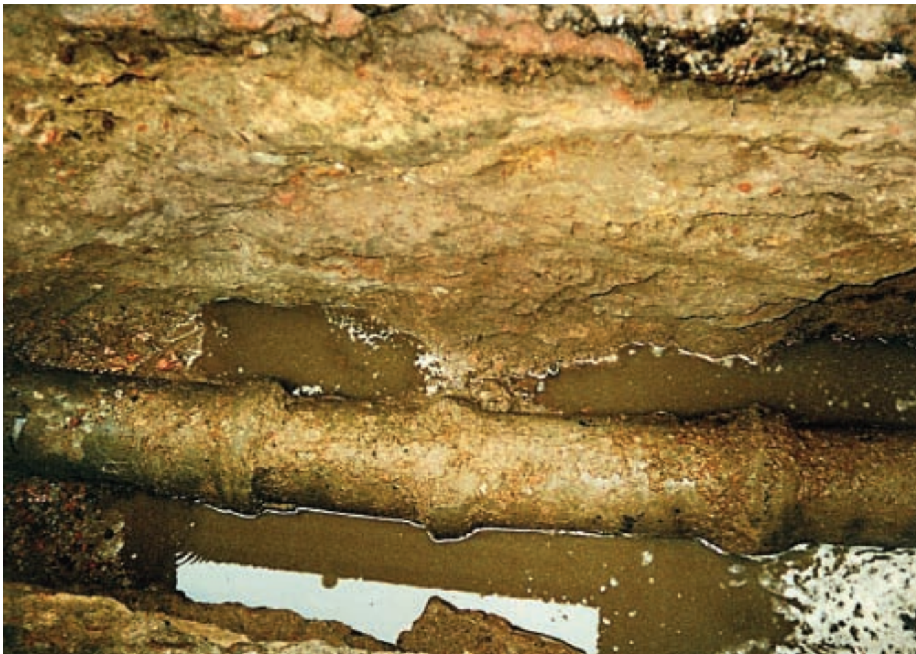
Цементно-бетонные трубы конца XIX в. системы В. Гюртлера из труб длиной 75 см, 1996
