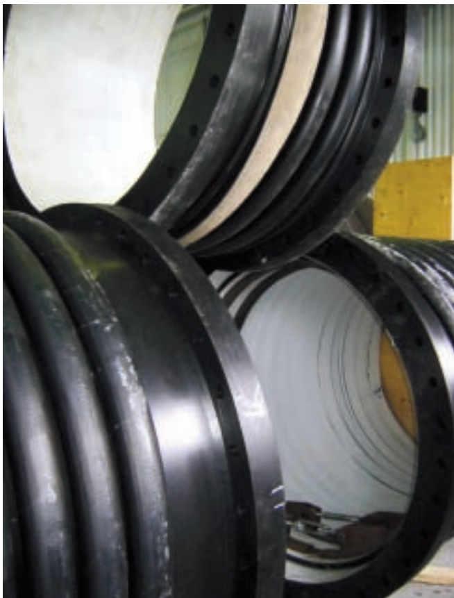
Рис. 3. На место поврежденного участка вставляется «катушка»
