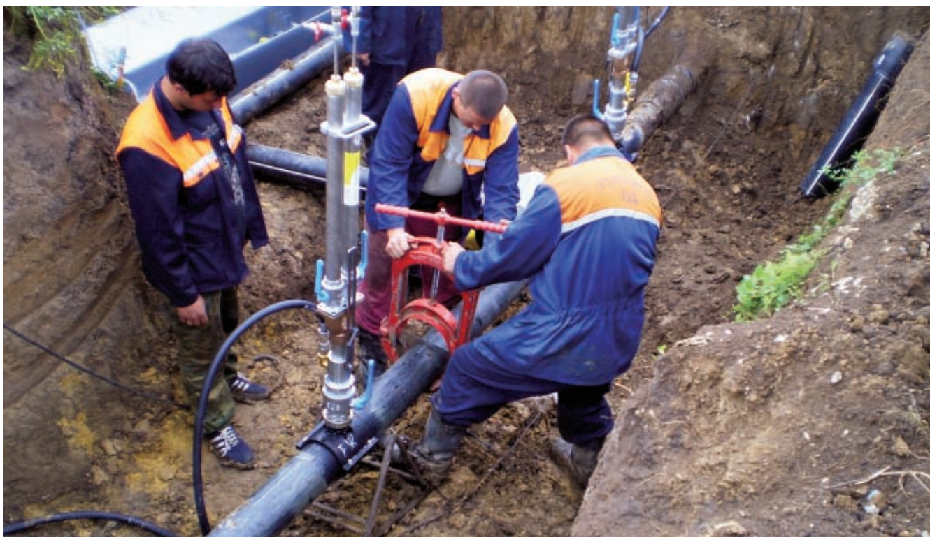
Рис. 5. Газопровод перекрыт шарами. Сотрудники ОАО «Тулагоргаз» начинают работы по подключению нового участка
