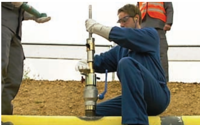
Рис. 4. Прорезка отверстия в газопроводе
