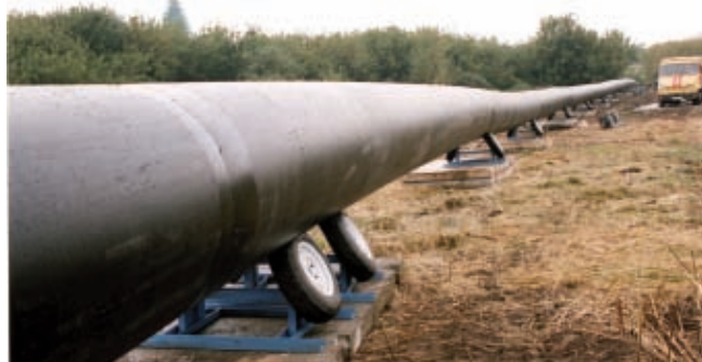
Рис. 3. Использование роликовых опор
