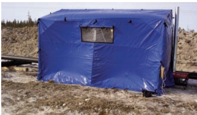
Рис. 2. Организация рабочего места сварщика – необходимое условие обеспечения качества сварки
