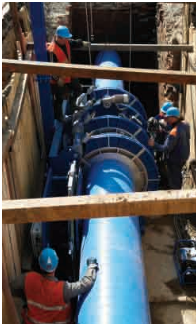
Рис. 6. Обустройство сварочного участка на дне траншеи.
