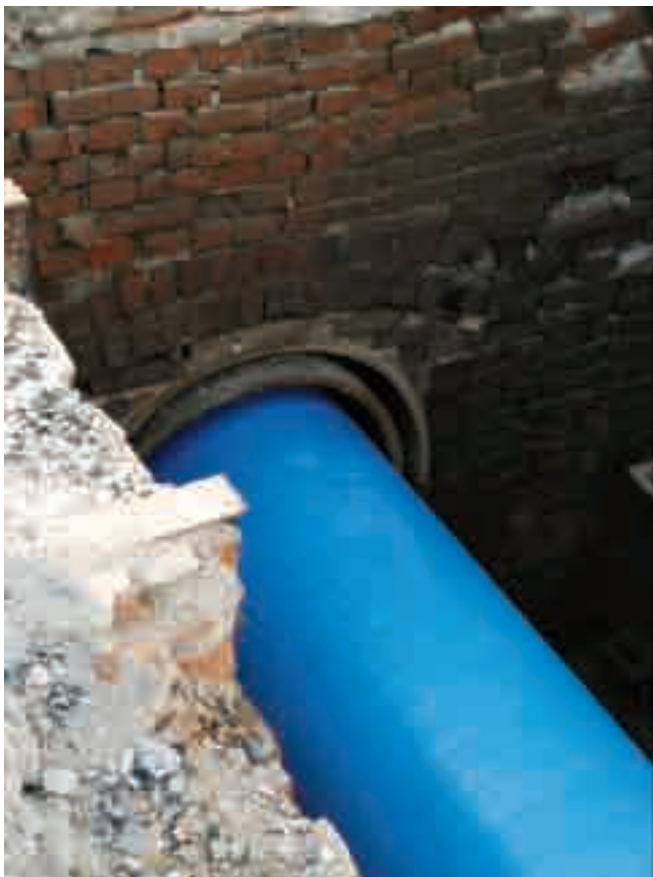
Рис. 7. Протягивание труб ПРОТЕКТ.
