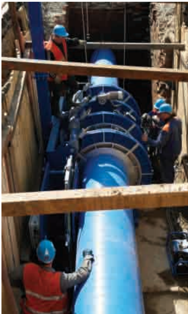
Рис. 6. Обустройство сварочного участка на дне траншеи.
