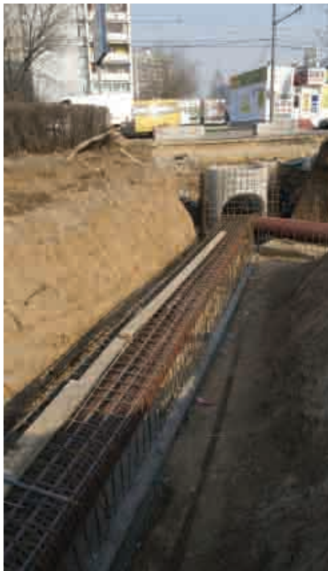
Рис. 2. Прокладка гофрированной трубы из полипропилена в железобетонном футляре.
