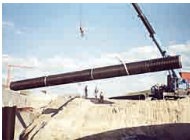
Рис. 2. Укладка в траншею плети труб КОРСИС ПЛЮС
