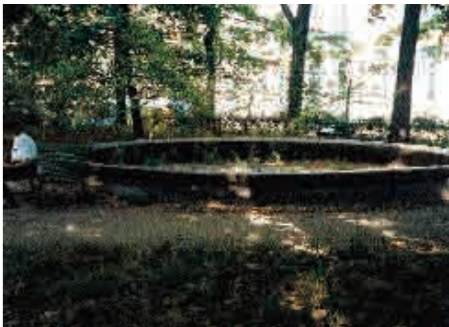
Рис. 2. Общий вид неработающего фонтана, 1998 г.
