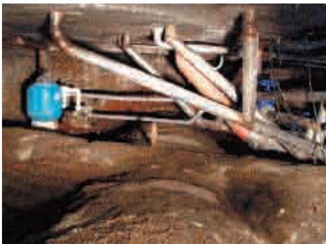
Рис. 4. Внутреннее пространство павильона фонтана после реконструкции 2003 г. Видны исторические кирпичные каналы Расстрелли сер.XVIII в.
