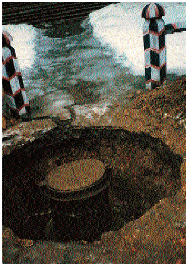
Рис. 5. Чугунная горловина цементно-бетонного колодца во дворе Зимнего дворца. Фото 1995 г.
