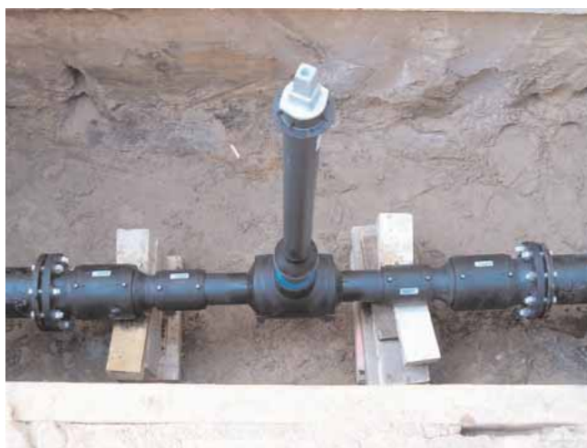
Рис. 8. Полиэтиленовая запорная арматура FRIALOC®, вмонтированная в чугунный трубопровод
