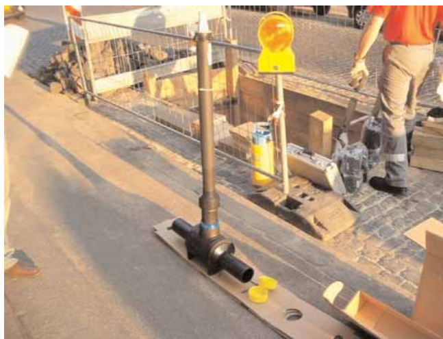
Рис. 8. Полиэтиленовая запорная арматура FRIALOC®, вмонтированная в чугунный трубопровод
