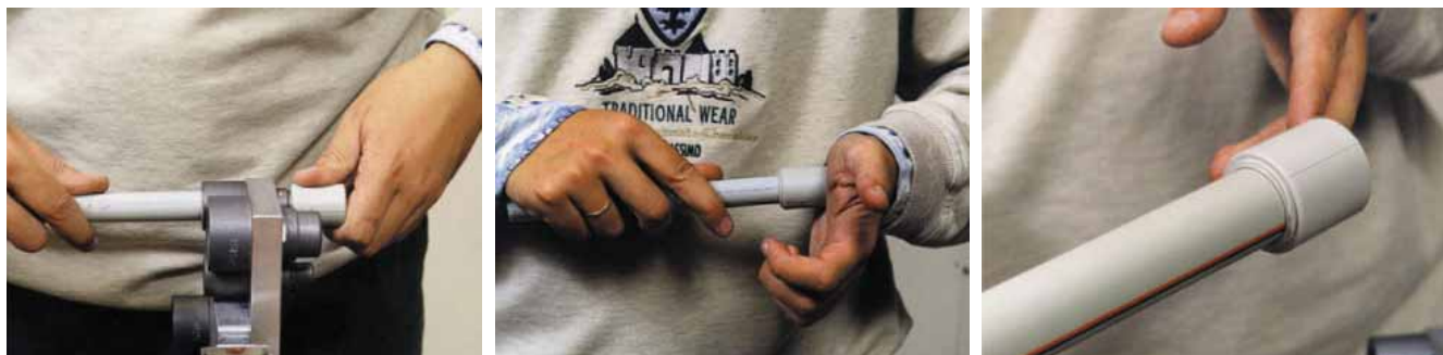
Рис. 2. Контактная тепловая сварка: быстрая и несложная процедура
