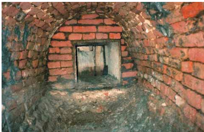
Рис. 6. «Щит с подъемным домкратом», установленный в канале
