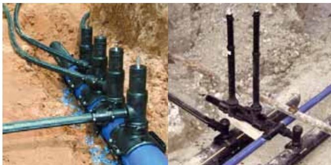
Рис. 2. Седелки с клапаном и встроенной фрезой для врезки Рис. 3. Краны-здвижки
