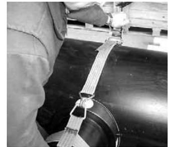
Плотно прижать накладной уход к трубе с помощью ремней.
