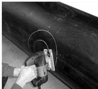
Просверлить на внутреннем круге отверстие  $\varnothing 10$  мм. С помощью электролобзика вырезать внутренний круг. Зачистить скребком плоскость сварки и очистить отверстие от стружки.
