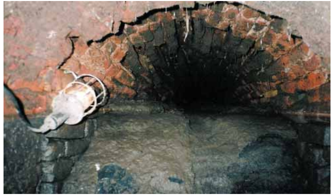
Рис. 6. Канал XVIII века в 1-м Церковном дворе Зимнего дворца до очистки. Сечение канала практически полностью забито уплотненными отложениями
