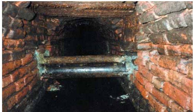
Рис. 7. Канал XVIII в. Прохождение водопроводных труб сквозь канал
