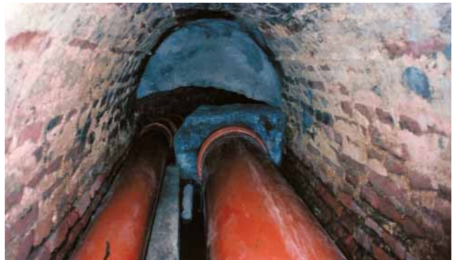
Рис. 8. Вид и кладка канала середины XIX в. на территории Большого Эрмитажа. Внутри в 1996 г. проложены новые трубы «Уропог» двух водоотводящих систем (бытовой и ливневой)
