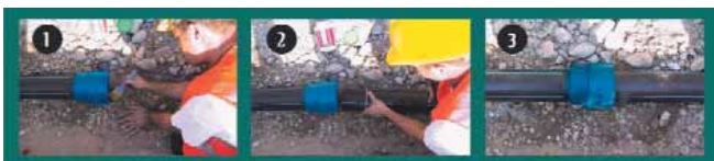
Рис.3. Последовательность монтажа раструбного соединения
