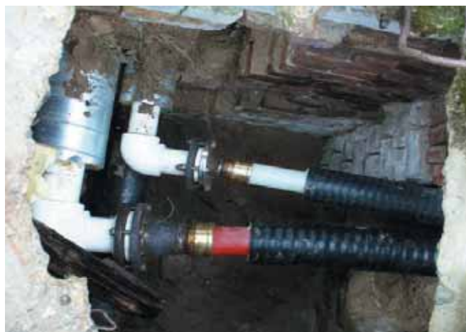
Узел соединения труб из сшитого полиэтилена с полипропиленовыми трубами
