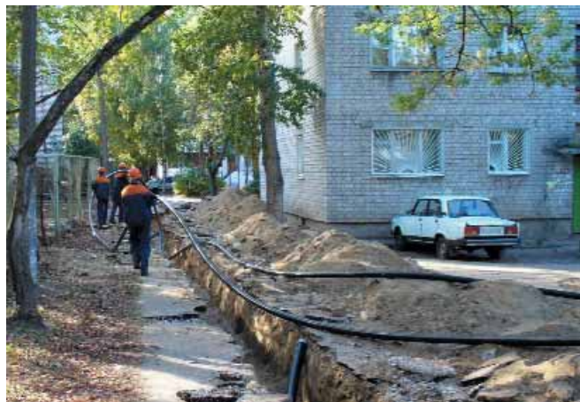
Монтаж и укладка труб «Изопрофлекс» в траншею
