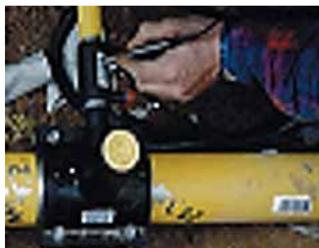
Рис. 7. Считывание параметров режима сварки и данных обратного отслеживания
