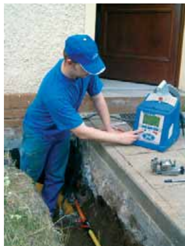
Рис. 10. Ввод данных посредством клавиш сварочного аппарата FRIAMAT.
