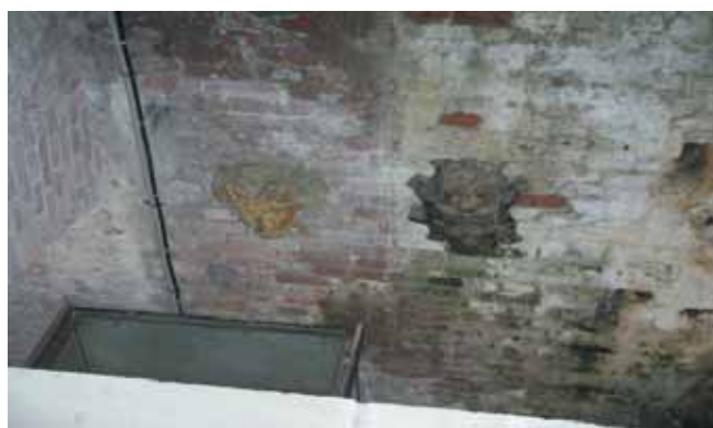
Рис.3 Современные трубы, подающие воду к дворцовым фонтанам, проложенные в старых водопроводных каменных каналах
