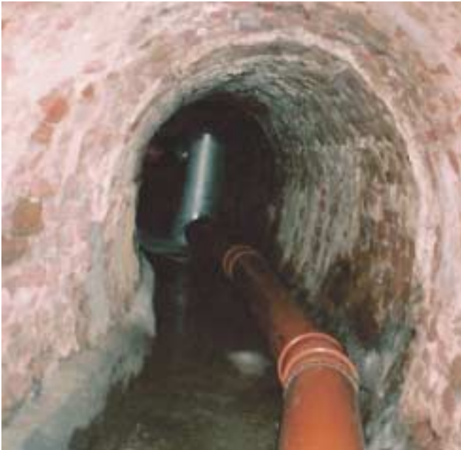
Рис. 6. Кирпичный канал середины XIX века на территории Зимнего Дворца. В 1996 году в нем были проложены новые трубы и установлены новые колодцы
