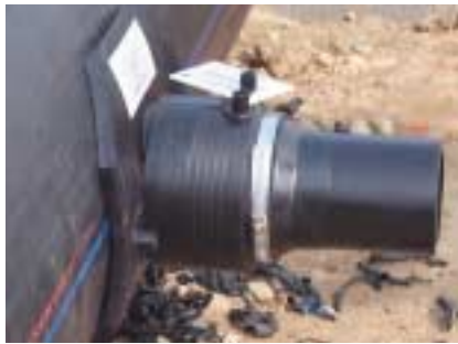
Рис. 6. Врезка при помощи седлового отвода (Novara, Италия)
