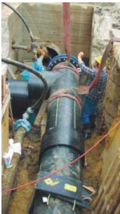
Рис. 2. Электромуфтовая сварка для труб диаметром до 630 мм
