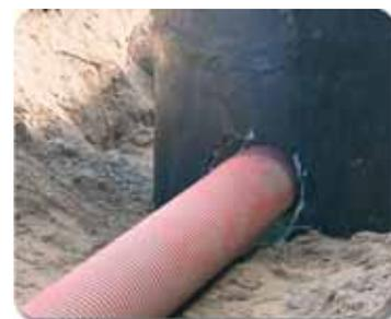
применять для строительства канализационных сетей, уложенных на глубине от 0,8 м до 8 м на участках без нагрузок, а также под дорогами с максимальной динамической нагрузкой до 40 тонн на ось транспортного средства.
