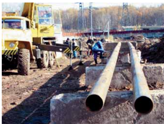
Сварочные работы на теплосети
