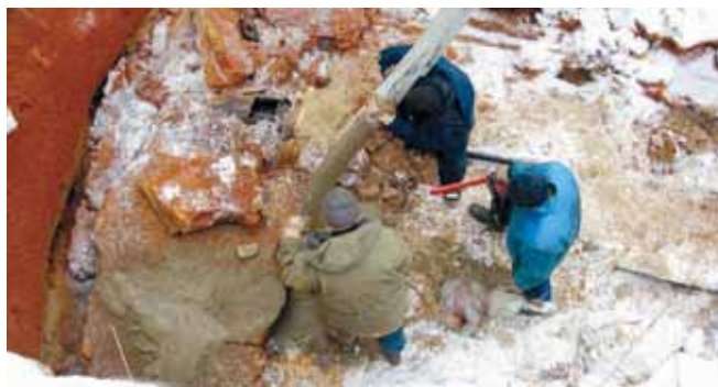
Заполнение бетоном футляра, переход через автодорогу
