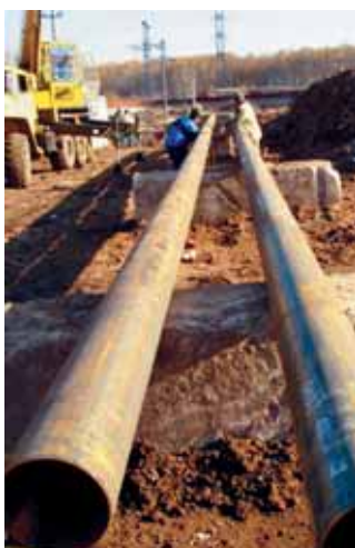
Монтаж и сварочные работы на тепловых сетях
