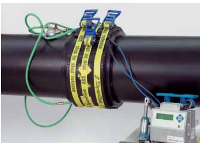
Рис. 4. Установка муфты с использованием комплекта прижимных пластин
