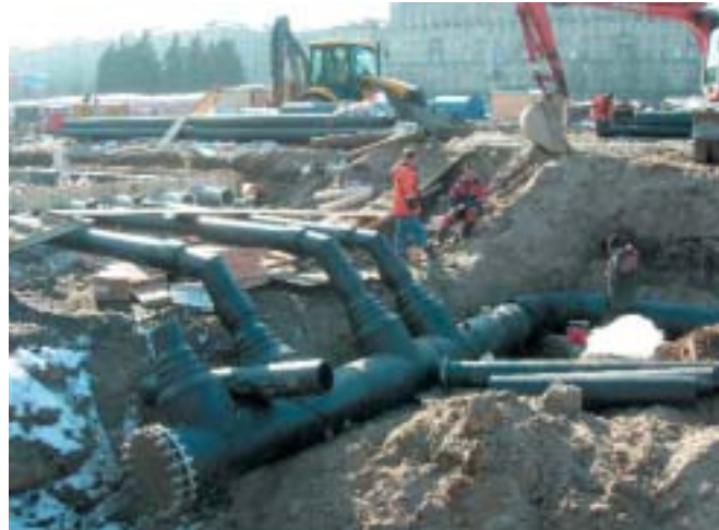
В кратчайшие сроки именно из ПЭ труб были изготовлены и поставлены сложнейшие узлы для фонтанного комплекса на площади у станции метро «Московская» в Санкт-Петербурге
