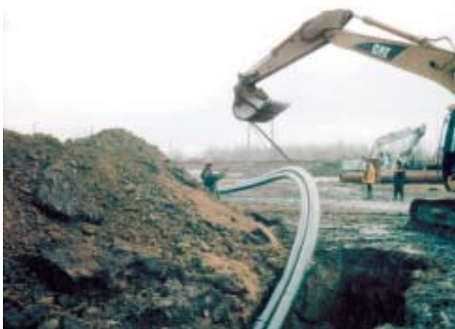
Применение ПЭ труб при строительстве сетей напорного водоотведения, Санкт-Петербург, Таллинское шоссе
