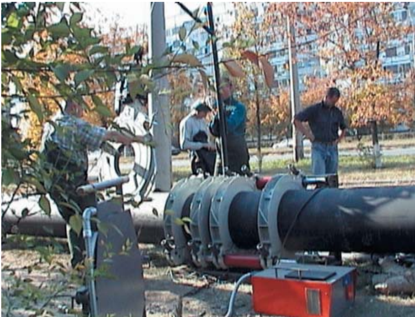
Рис. 3. Практическое обучение специалистов на машине УСПТЭП 630, снабженной компьютерным БРПС
